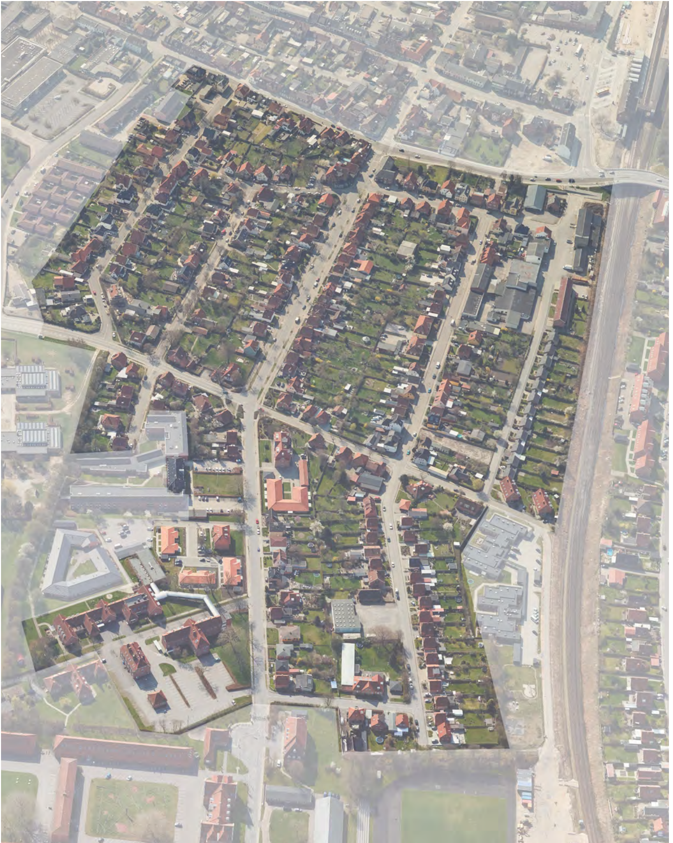
Udsnit af Boulevardkvarteret med ca. områdeafgrænsning. Skråfoto: Klima-, Energi- og Forsyningsministeriet.
