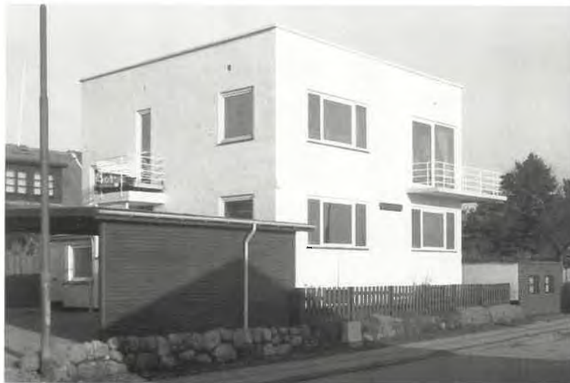
Et typisk funktionalistisk præget hus fra 1930'erne. Bemærk den kubiske form, den manglende gesims eller anden overgang til taget samt altanen, der er støbt i jernbeton og hænger frit ud fra facaden.
