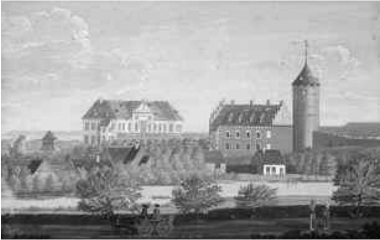
Prins Jørgens Palæ set fra nord. Til venstre ses en lille pavillonbygning opført på resterne af Jomfrutårnet, oven på resterne af den store ringmur. Til højre ses Gåsetårnet sammenbygget med den senmiddelalderlige bygning kaldet "Fruestuerne" - en af de få bygninger fra den gamle borg, der blev stående efter opførelsen af Prins Jørgens Palæ. (Johan Jacob Bruun, gouache 1744, Nationalmuseet)
